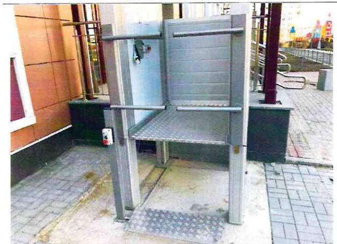
Фото №25 – Вертикальный подъемник до уровня входной площадки входа №3
